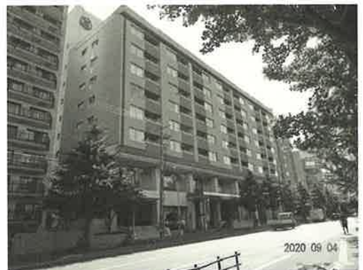
2020年札幌市中央区の外断熱改修マンション～改修時築47年、1～2階店舗を含む8階建て、3～8階住戸（60戸）専有部分外壁の外断熱改修を行う
