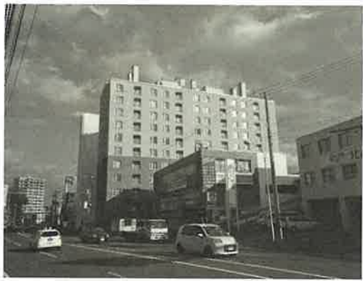
2017年札幌市豊平区の外断熱改修マンション～改修時築43年、11階建て60戸、住民の高齢化、世代交代も展望し、外壁、屋上の断熱改修と窓サッシの交換を行う
