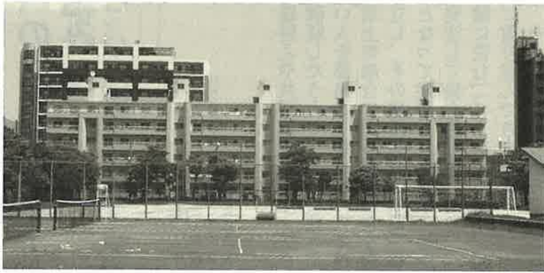
2023年4月着工の札幌市東区Nマンション～築34年、6階建て58戸、外壁、屋上の断熱改修と窓サッシの交換を予定、現在、長期優良住宅化リフォーム補助事業申請中
