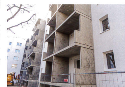
写真6 改修建物のバルコニー。既存の熱橋対策として自立型プレキャストで新設
