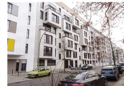
写真4 ベルリン市内ポイエンストリートに建つ集合住宅
