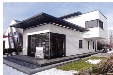
写真2 LUXAUS社の110㎡の工場生産によるプレハブ住宅
